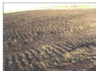
Фото 3. Площадка биовосстановления грунта с амбара № 5 через год после первичной очистки. Уровень остаточного содержания нефти – до 40 г/кг. Снижение уровня загрязнения грунта за летний период составило 75%.
