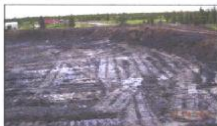
Фото 2. Фрагмент амбара № 6, очищенного от нефтесодержащей жидкости и нефтезагрязненного грунта. Подлежит ремонту и подготовке к дальнейшей эксплуатации или подвергается технической рекультивации с последующим фитовосстановлением
