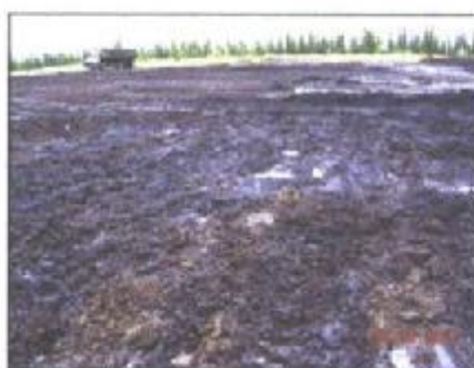
Фото 5. Площадка биовосстановления представляет собой выработанный до глиняного основания бывший песчаный карьер. Перед началом работ на глиняный экран выкладывают слой гидрофильного субстрата (например, торфа). Нефтезагрязненный грунт после первого этапа очистки выгружают на оторфованную площадку и далее подвергают трехступенчатой обработке биопрепаратом, удобрением и микроэлементами. Периодическое фрезерование является обязательным условием для оптимизации процесса биоремедиации загрязненного нефтью субстрата.
