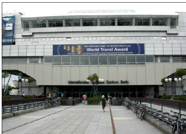
Здание международного конгресс-центра в Берлине.
