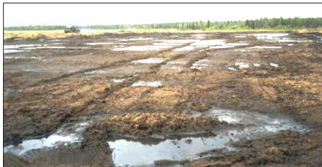
Фото 4. Вид участка 4 «С», секция 1 после осушения, драгирования, внесения удобрений и обработки биопрепаратом.
