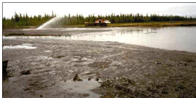
Фото 2. Проведение первичной технической рекультивации на секции 1 участка 4 «С» – смыв и локализация десорбированной из донного грунта и всплывшей на поверхность нефти, откачка нефтесодержащей жидкости вакуумбочками.
