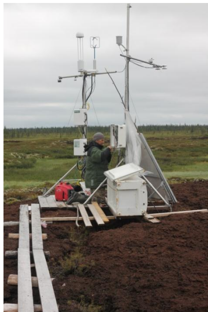
Вед. инженер Швецов С.П. проводит монтаж измерительной системы на болоте
