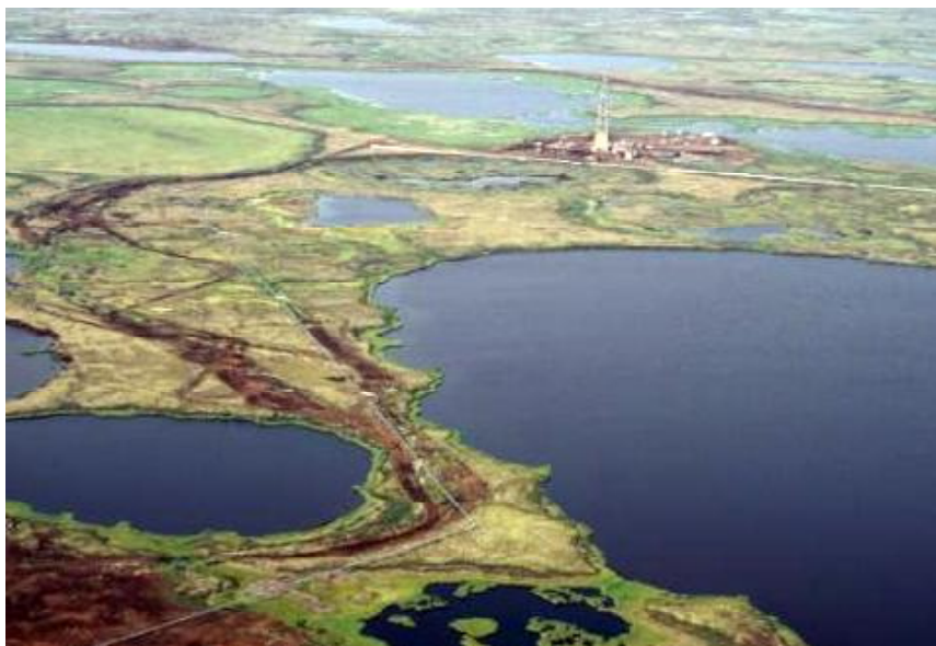
Нефтедобывающая платформа и трубопровод в окрестностях Колвы (© В. Пономарев).
