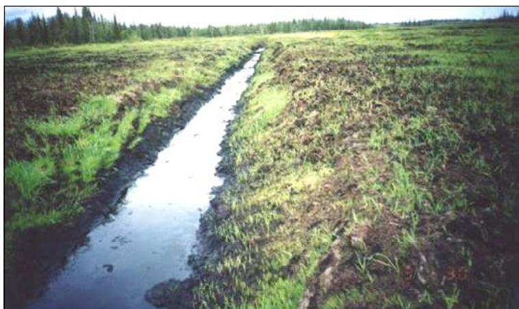
Фото 27. Участок № 26 (ЦДНГ-4) через год после завершения рекультивации и сдачи участка. Почва на участке чистая, происходит рост высеянных злаков, дренажный канал используется для локализации и сбора избытка нефти. Подрядчик ООО «Могилевводстрой».
