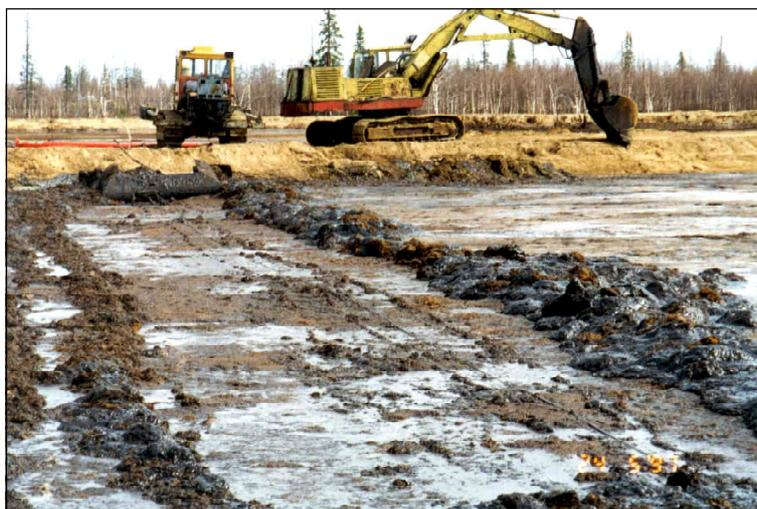
Фото 6. Очистка поверхности загрязненного нефтью болота методом драгирования с последующей экскавацией и вывозом загрязненного грунта.
