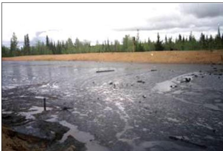
монакопитель, устроенный в 1995 г. в существовавшем карьере суглинка, представлял собой котлованы, заполненные водой и локализованные земляными дамбами (фото 9).
