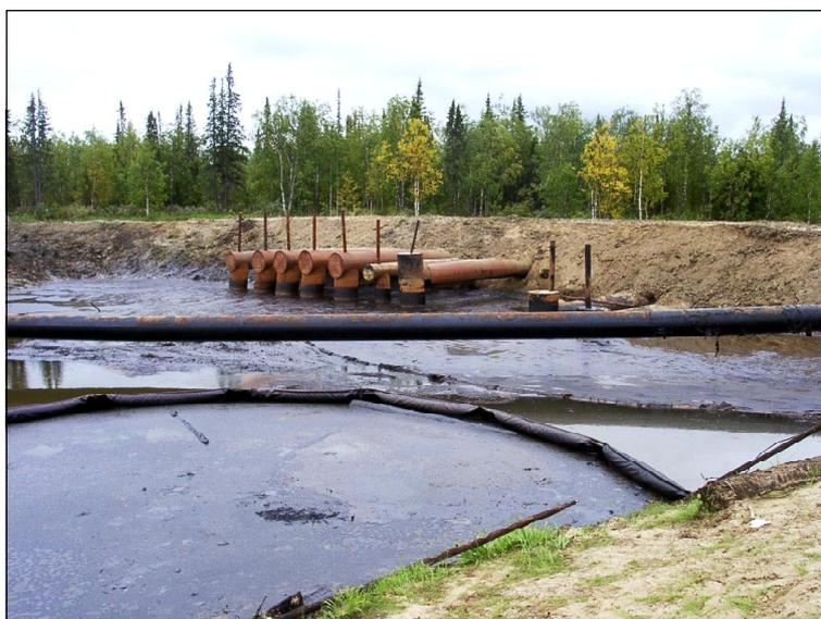
Фото 3. Фрагмент гидрозатвора с ограждающей дамбой в верхнем бьефе для локализации и сбора нефти.
