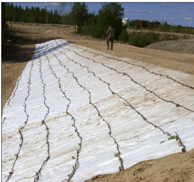
Фото 1. Фрагмент откоса дамбы, закрепленного нетканым полотном.
