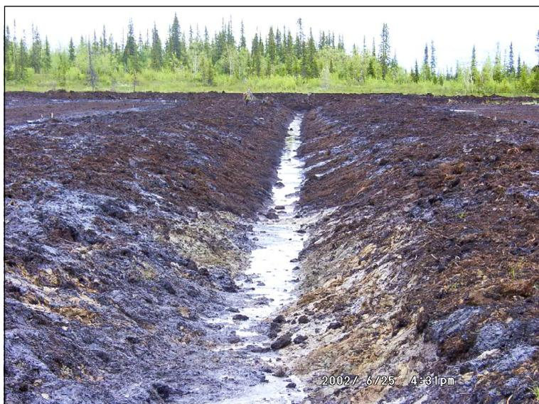
Фото 2. Устройство открытого канала на участке № 20 (ЦДНГ-4).
