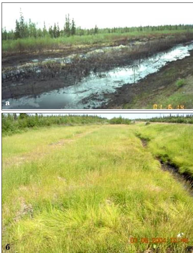
Фото 26. ЦДНГ-4, участок № 37 перед началом работ (а), уровень загрязнения почвы – около 450 мг/г. Через три года после завершения работ (б). Подрядчик работ – ООО РЦРНЗ.
