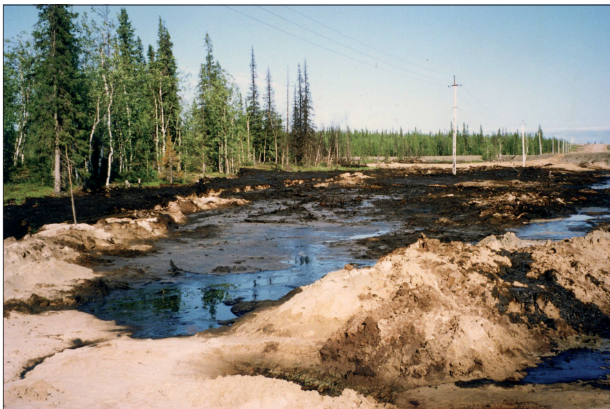
Аварийные разливы нефти на нефтепроводе «Возей–Головные Сооружения», 1996 г.
