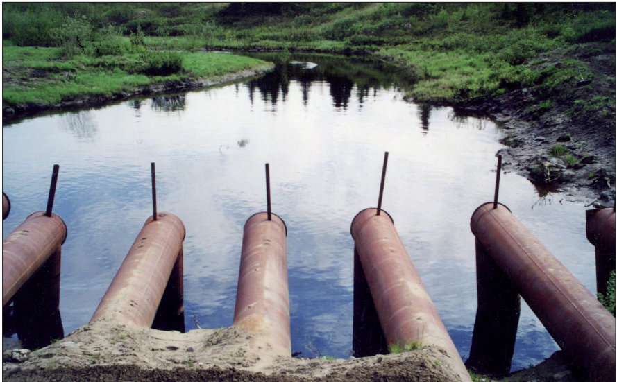
Верхний бьеф гидрозатвора на руч. Большой Кеню, 1998 г.
