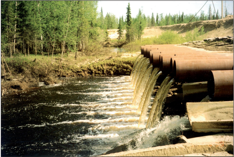
Один из многочисленных гидрозатворов, построенных в период очистных работ для улавливания нефти (руч. Пальник-шор, 1998 г.). Нижний бьеф.
