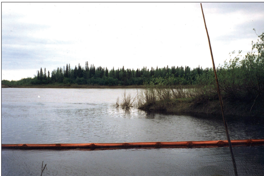
Боновое заграждение для сбора легких фракций нефти в устье руч. Большой Кеню, 1996 г.
