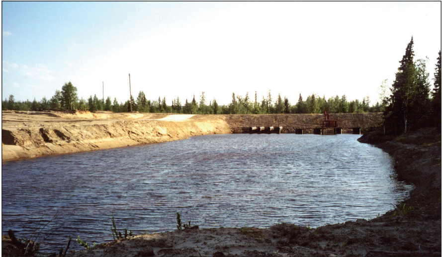
Верхний бьеф гидрозатвора на руч. Ниедзьель.
