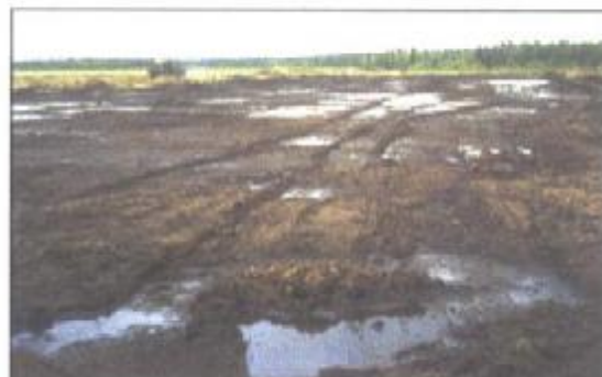
Фото 3. Вид участка 4 «С», секция 1 после осушения, драгирования*, внесения удобрений и обработки биопрепаратом. Подрядчик работ ТОО СПАСФ «Природа», Усинск.
