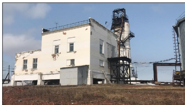
Здание вентиляционного ствола СП «Шахта Заполярная» (фото М.Г. Билаловой).
